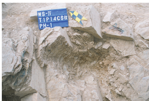
圖九 修整岩盤
