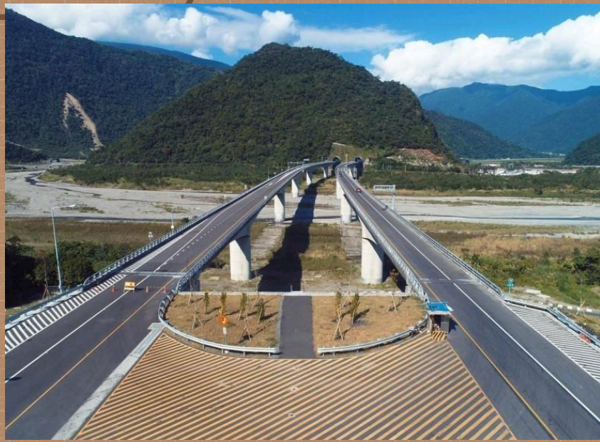
武塔高架橋 / 圖片來源蘇花公路改善工程處
